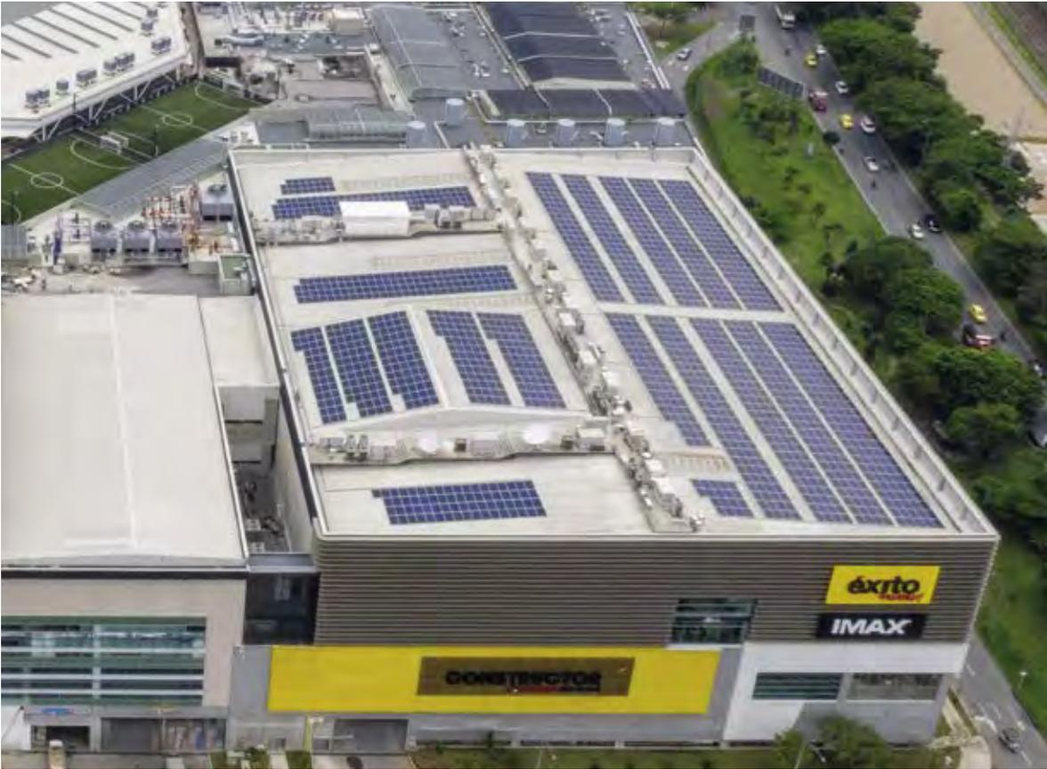
En Viva Envigado está la quinta planta fotovoltaica de la compañía. Con 2.700 m<sup>2</sup> de paneles solares genera alrededor de 451 kw/h y suple hasta un 20% del consumo de las zonas comunes del centro comercial en horarios de máxima radiación solar.
